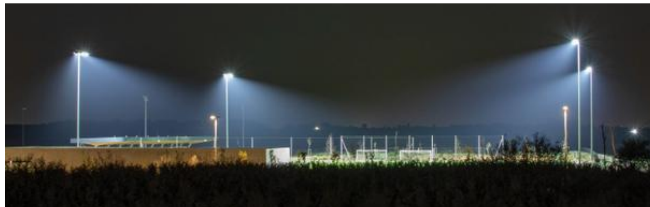
Dispositif de type « Full Cut-off » pour masquage des sources et coupe-flux
